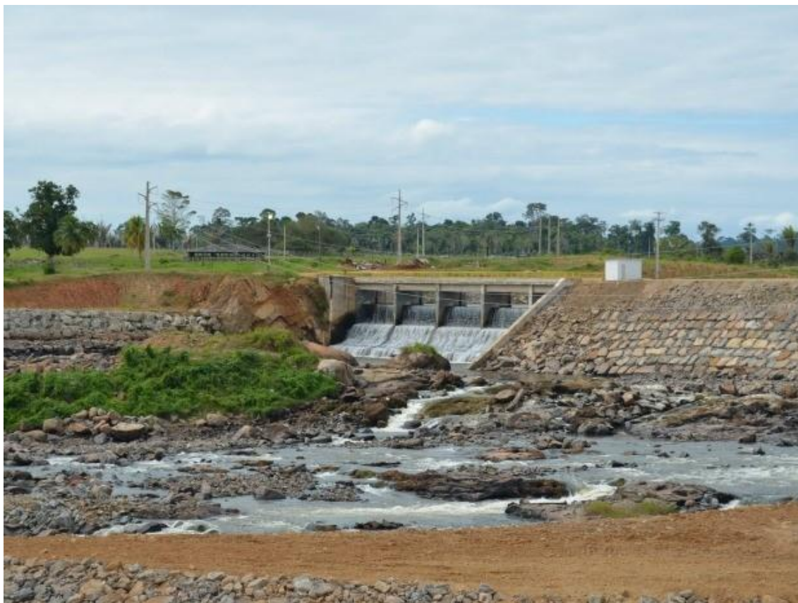
Pequena Central Hidrelétrica Santa Cruz, em Monte Negro (Foto: Eliete Marques/G1)
